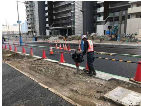
写真 6.8.6-6 再生碎石の使用
