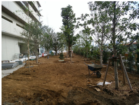
写真 6.8.3-1 植栽基盤の施工の状況
