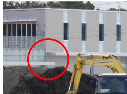
写真 8.6-2 管理棟 (底部分のアップ)
