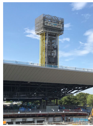
写真 8.9-6 リフトアップ工法の状況
