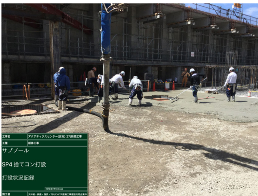
写真 8.9-7 再生骨材コンクリート打設
