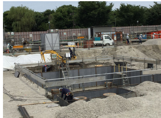
写真 8.9-4 鋼製型枠の使用
