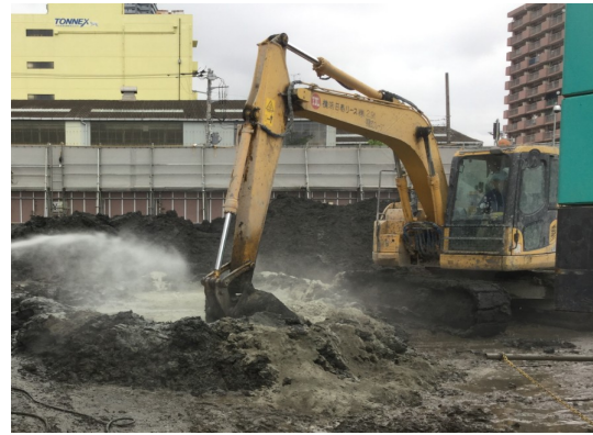
写真 8.9-2 建設泥土改良状況
