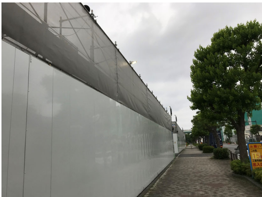
写真 8.5-9 仮囲い及びメッシュシート
