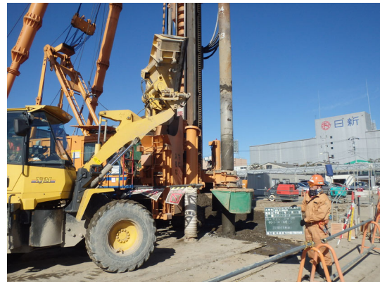
写真 8.5-12 静的締固め砂杭工法
