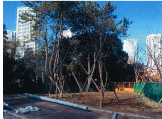
写真 8.2-4 支柱設置状況
