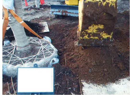
写真 8.2-2 良質土による埋戻し
