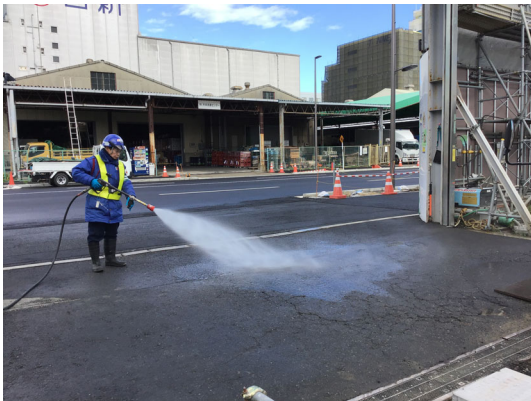
写真 8.1-11 路面清掃状況
