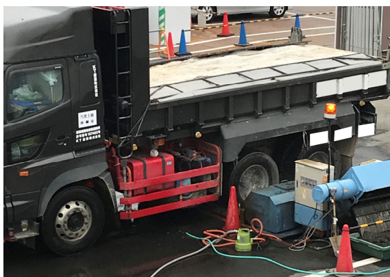
写真 8.1-3 タイヤ洗浄設備
