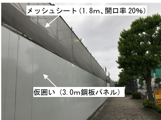
写真 8.1-13 仮囲い及びメッシュシート
