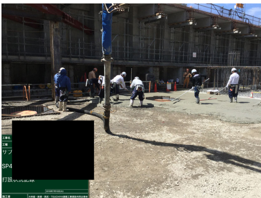
写真 8.10-1 再生骨材コンクリート打設
