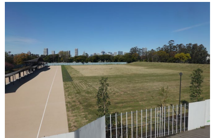
夢の島公園アーチェリー場 (2019 年(平成 31 年)2 月竣工)
