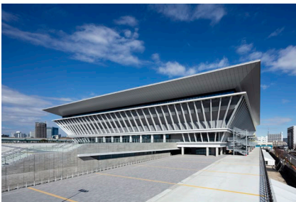
東京アクアティクスセンター (2020 年(令和 2 年)2 月竣工)
