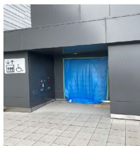
<屋外エレベーター扉の防水措置>
