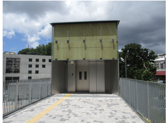
エレベータの設置
