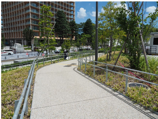
スロープの設置
