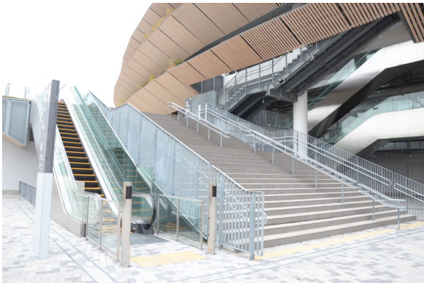
エスカレータの設置
