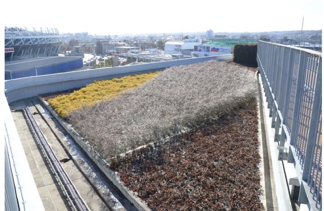
サブアリーナの屋上緑化 (ヘデラ、アベリア、フィリフェラオレア)
