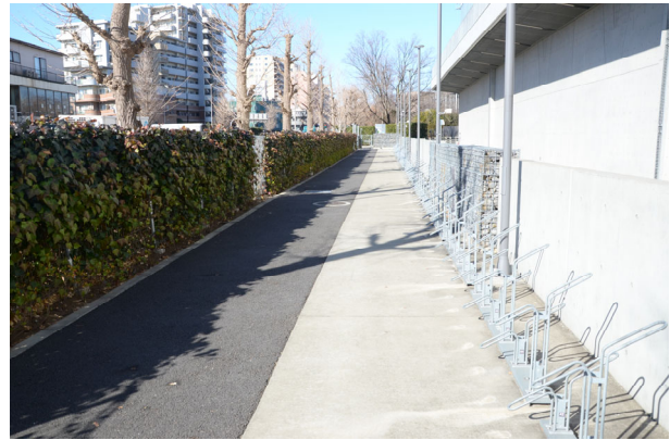
地中熱利用設備埋設箇所
