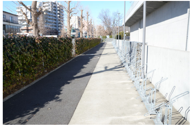
地中熱利用設備埋設箇所
