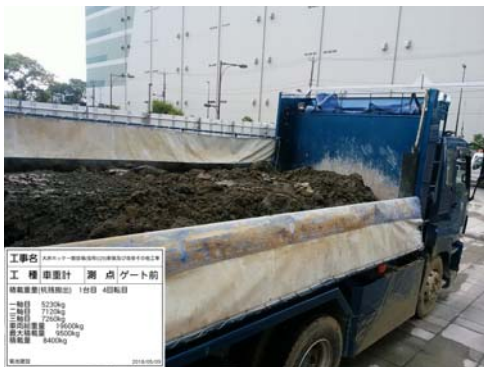
写真 8.6-3 建設汚泥再資源化施設搬出時
