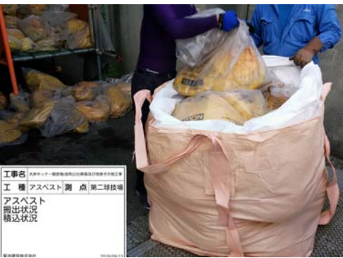
写真 8.6-5 アスベスト保管作業状況
