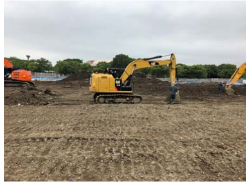
写真 8.6-2 発生土の場内利用
