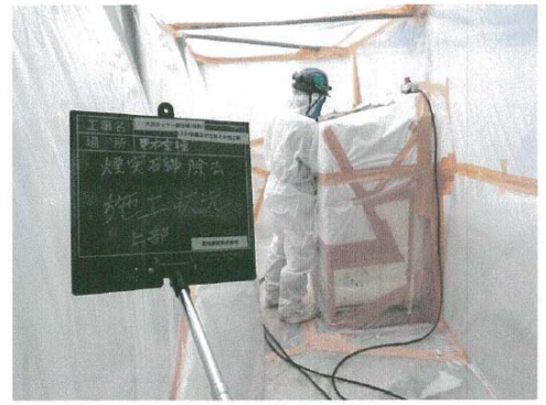
写真 8.6-4 アスベスト解体工事
