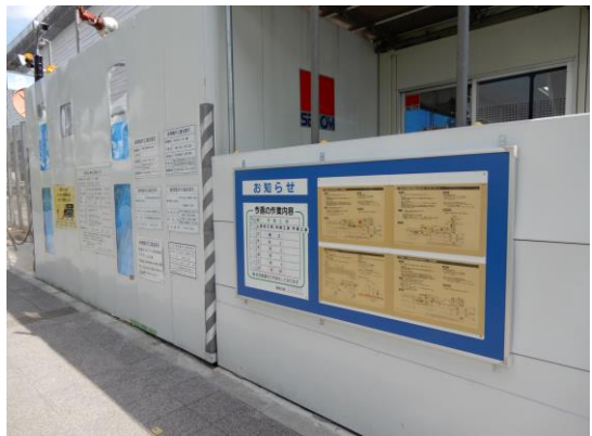
写真 8.5.1-13 近隣窓口問い合わせ先掲示板
