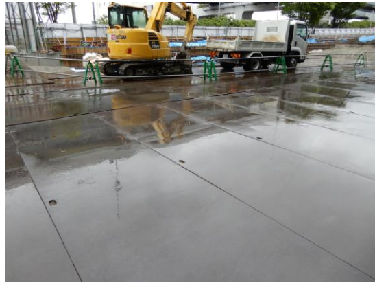
写真 8.5.1-2 鉄板敷設状況
