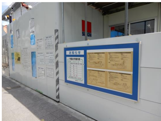
写真 8.5.2-7 近隣窓口問い合わせ先掲示板
