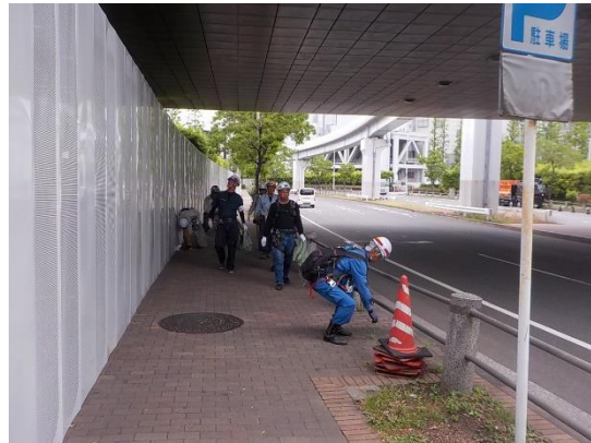
写真 8.3.1-4 歩道清掃の状況
