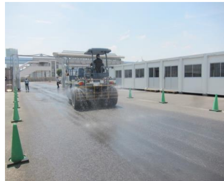
写真 8.2.1-14 作業動線のアスファルト舗装
