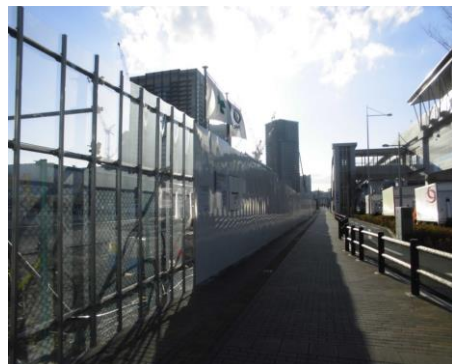
写真 8.2.1-10 仮囲いの状況
