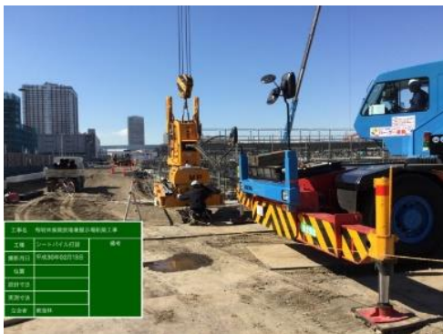
写真 8.2.2-11 サイレントパイラー工法の採用
