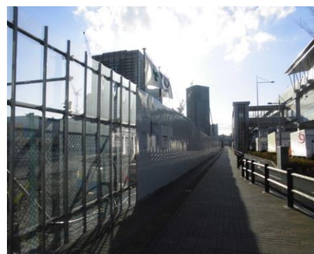
写真 8.2.2-6 仮囲い設置状況
