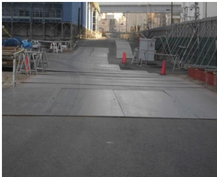
写真 8.2.1-13 場内走行路（鉄板敷）
