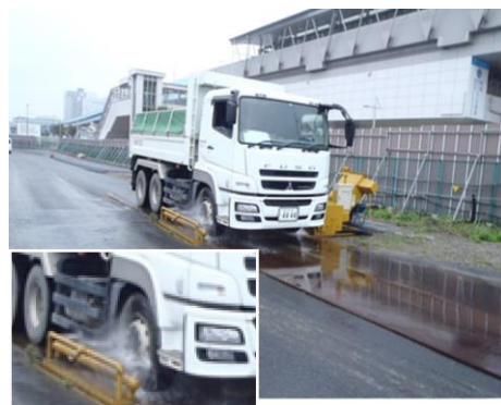
写真 8.2.1-2 タイヤ洗浄装置
