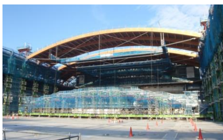
写真 8.2.5-1 木造化・木質化箇所
