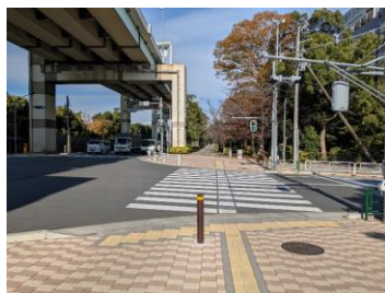
三ツ目通り (誘導ブロック・勾配改善)
