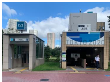
辰巳駅 (新設エレベーター)
