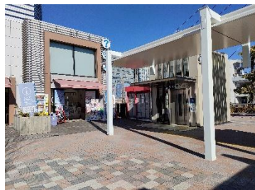
エレベーター整備 (東京レポート駅)
