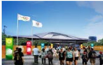
02_Tokyo Metropolitan Gymnasium 東京体育館
