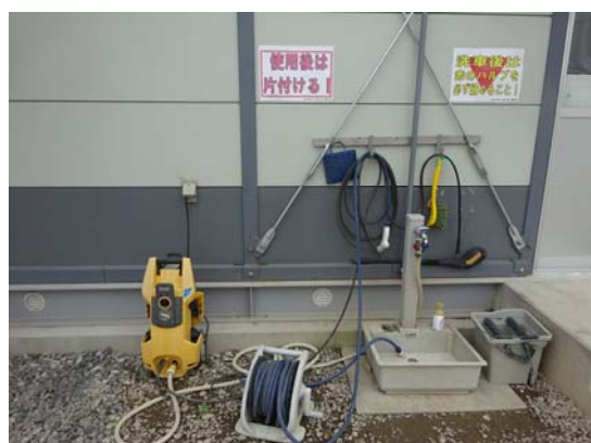
写真 8.1-4 タイヤ洗浄装置
