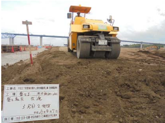
写真 8.1-1 発生土現場内利用
