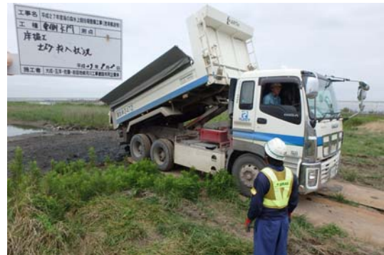
写真 8.1-2 発生土の中央防波堤区内利用
