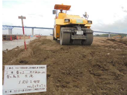
写真 8.13-2 発生土現場内利用
