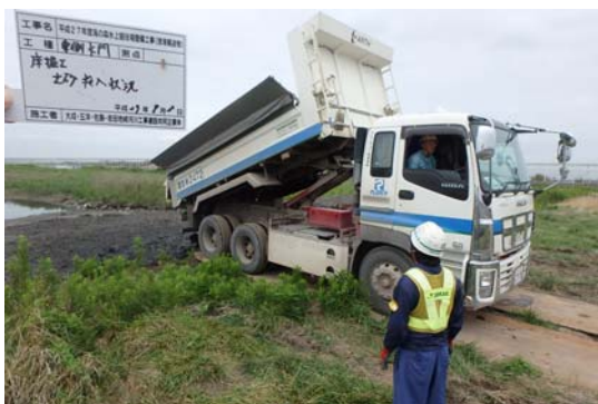
写真 8.13-3 発生土の中央防波堤区内利用
