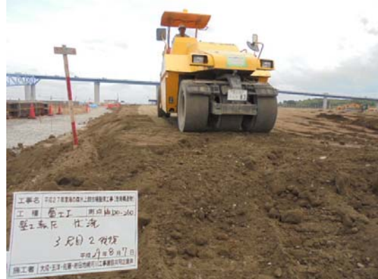
写真 8.10-2 発生土現場内利用
