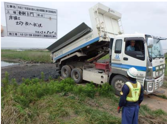
写真 8.10-3 発生土の中央防波堤区内利用
