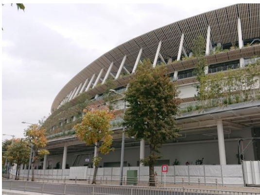
写真 8.9-5 外周の低層部の軒庇と鉛直柱
