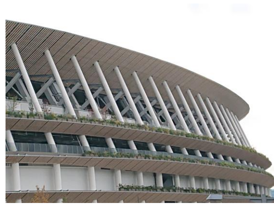
写真 8.9-2 最外周柱の最上部
