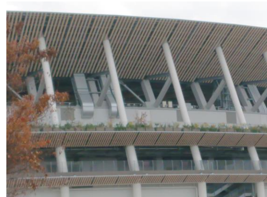
写真 8.9-4 軒庇の連続した縦格子
