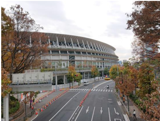
写真 8.9-3 連続した軒庇
