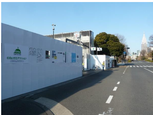
写真 8.7-5 仮囲い設置状況 (高さ 3.0m)
