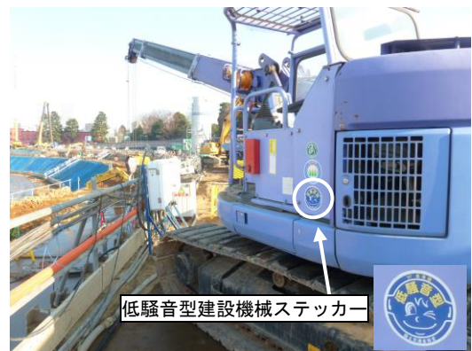
写真 8.7-4 低騒音型建設機械の使用
