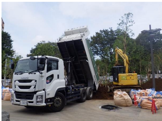
写真 8.6-15 植栽基盤工（客土）
