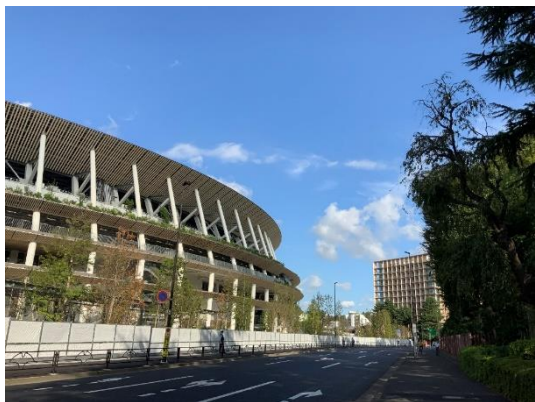
写真 8.6-13 階層構造緑化（計画地東・北側）
