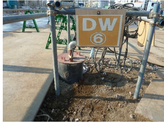
写真 8.4-2 ディープウェル工法
