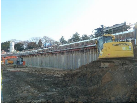
写真 8.4-1 SMW 施工状況
