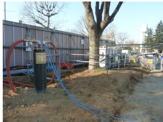
写真 8.4-4 リチャージウェル工法
