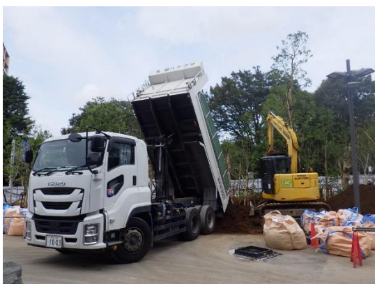
写真 8.3-13 植栽基盤工（客土）
