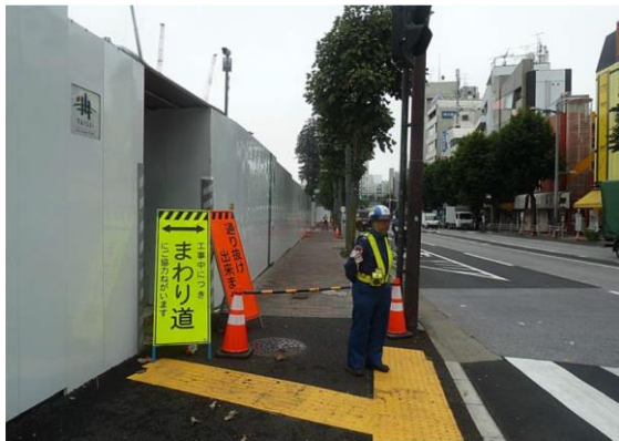
写真 8.24-3 代替路の設置
