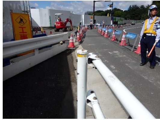
写真 8.24-2 道路占有工事での歩行者安全対策
