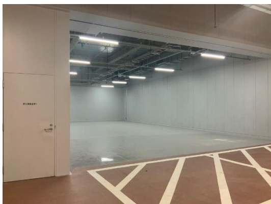
写真 8.22-7 防災備蓄倉庫
