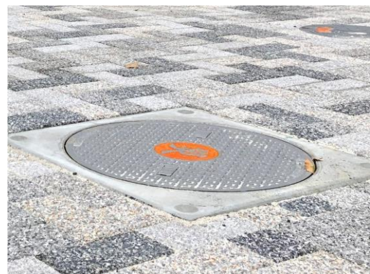
写真 8.22-8 マンホールトイレ
