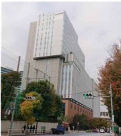
写真 8.20-1 日本青年館・日本スポーツ振興センター本部棟
