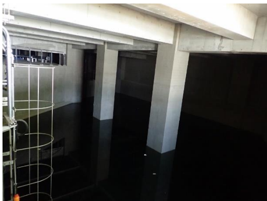
写真 8.13-1 雨水貯留槽
