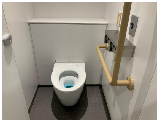
写真 8.13-2 節水型トイレ
