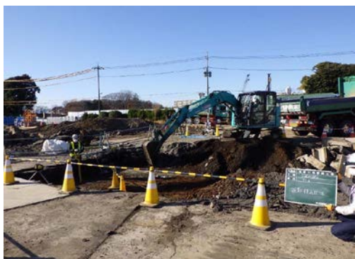
写真 8.2-1 汚染土壌の掘削除去
