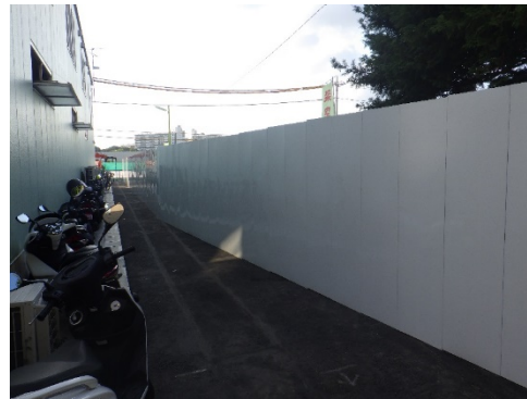
写真 8.1-12 南エリア地下道スロープ施工範囲における鋼製仮囲い (2m)
