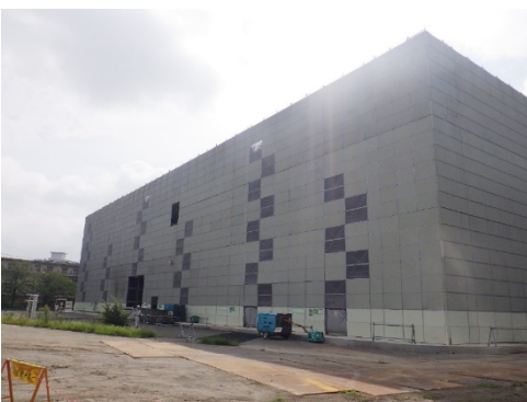
写真 8.1-15 工事範囲周辺の防じんカバー
