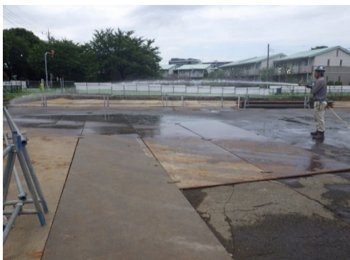
写真 8.1-21 鉄板の設置及び清掃
