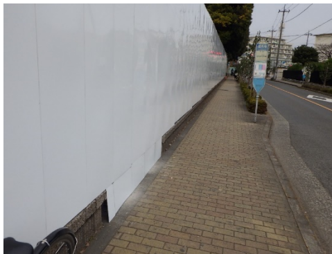
写真 8.1-11 北エリア地下道スロープ施工範囲における鋼製仮囲い (3m)
