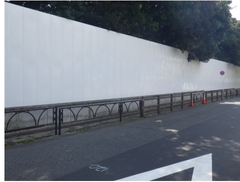
写真 8.1-10 北エリアにおける鋼製仮囲い (3m)
