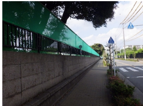
写真 8.1-20 飛散防止シート
