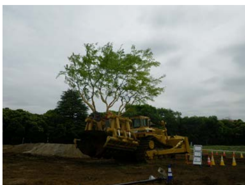
写真 8.7-5 モミジの移植状況
