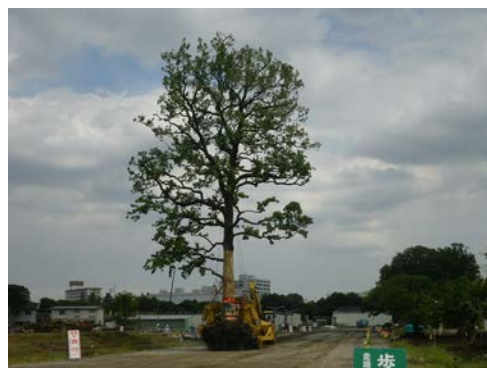
写真 8.6-6 クヌギの移植状況
