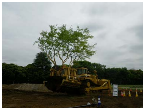
写真 8.6-5 モミジの移植状況
