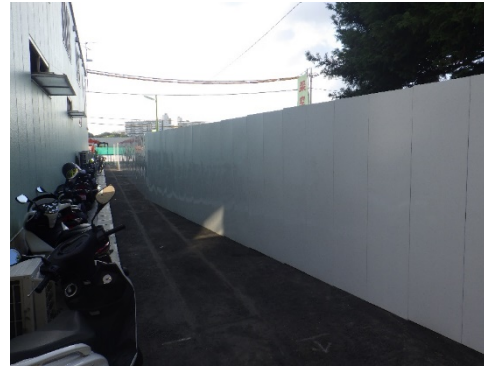
写真 8.5-8 南エリア地下道スロープ施工範囲における鋼製仮囲い (2m)
