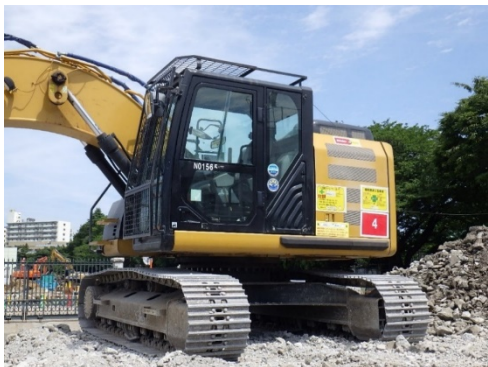
写真 8.5-11 超低騒音型建設機械
