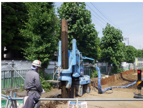
写真 8.5-13 サイレントパイラー工法
