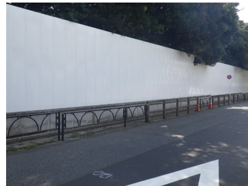
写真 8.5-6 北エリアにおける鋼製仮囲い(3m)
