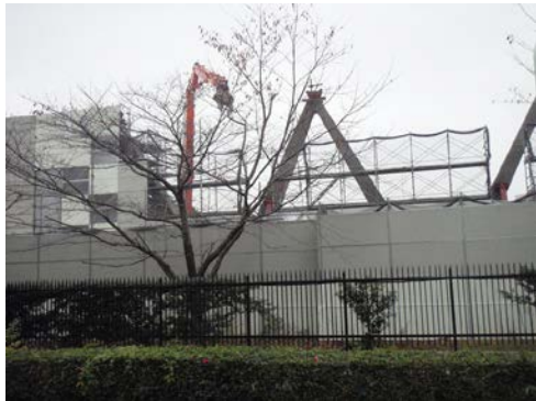
写真 8.5-9 パネル+防音シート
