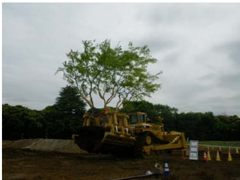
写真 8.4-5 モミジの移植状況
