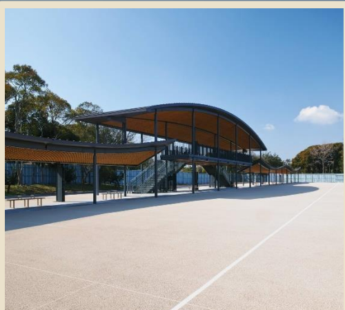
休憩舎（日よけ屋根）
