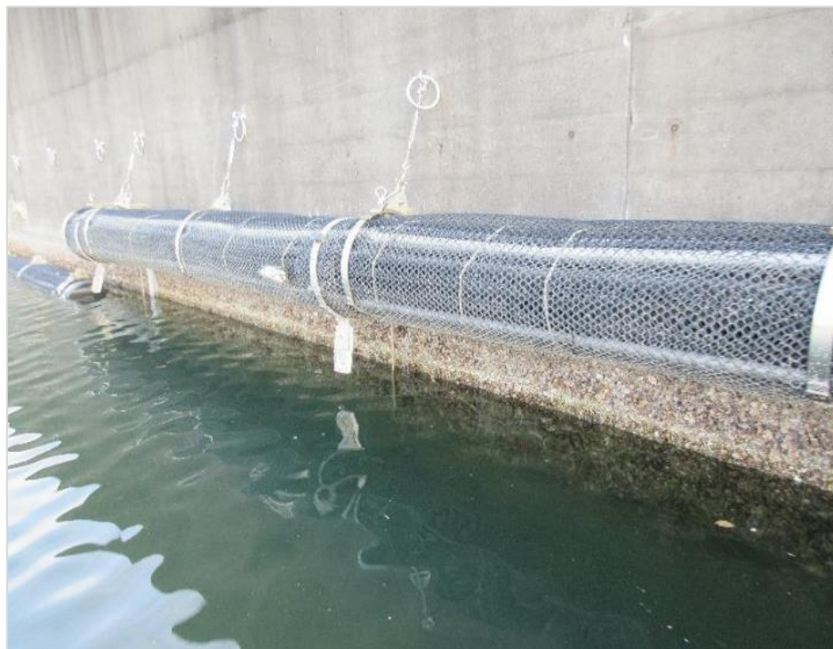
写真① 全景写真
