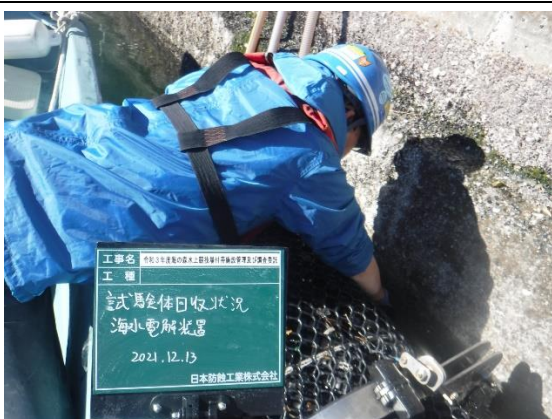
海水電解装置試験片回収状況
