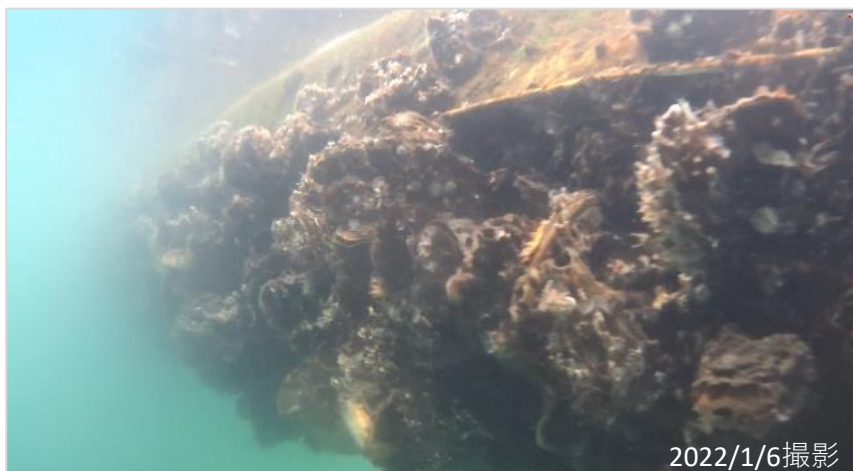
写真③ 水中部
