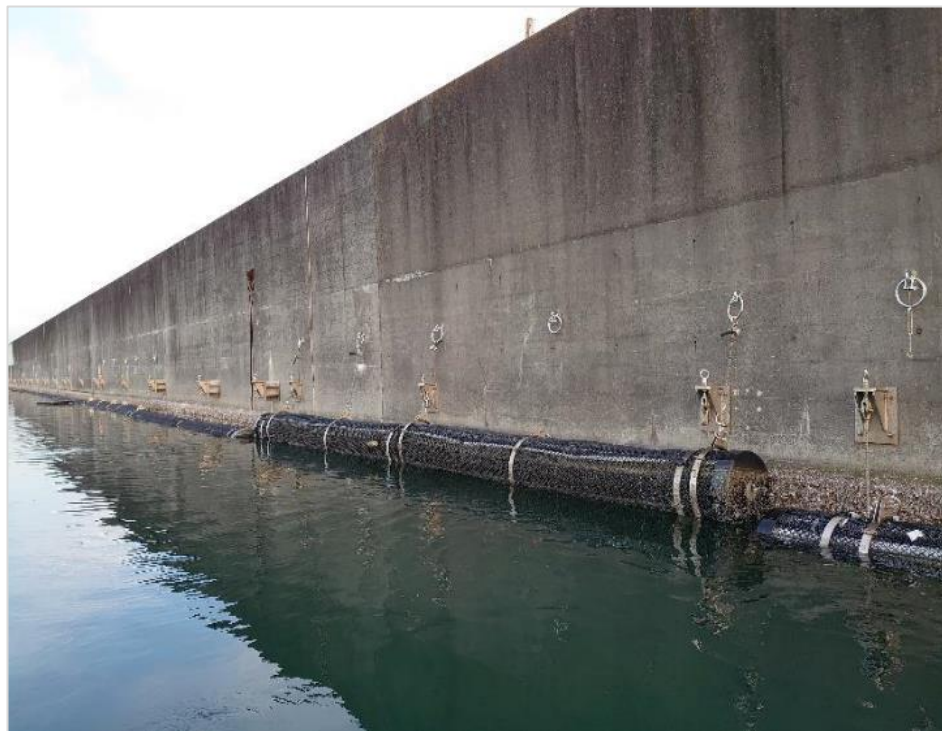
写真① 全景写真
