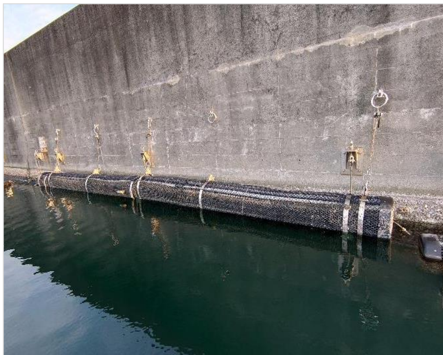
写真① 全景写真
