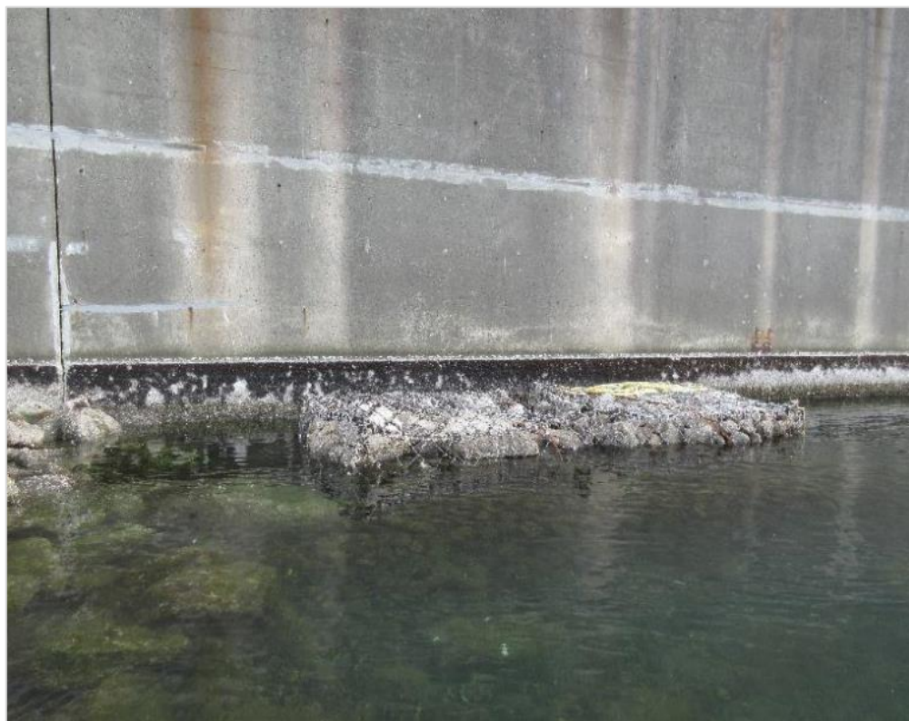
写真① 全景写真
