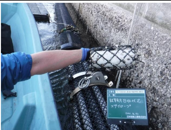
吊上げ案(4週干出)試験片回収後
