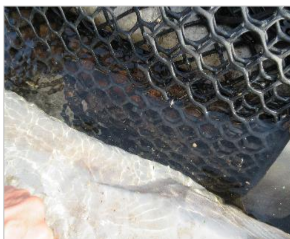
写真③ シート内部確認
