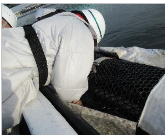
写真② シート内部確認
