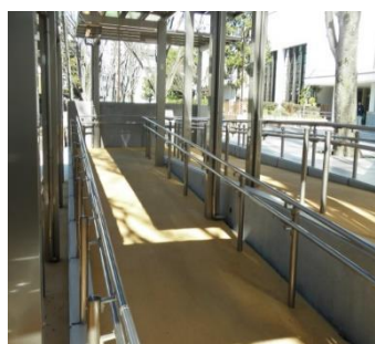
＜施設出入口のスロープ改修工事＞ [2]
